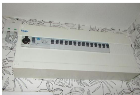
Modern lägenhetscentral med dvärg- och jordfelsbrytare
