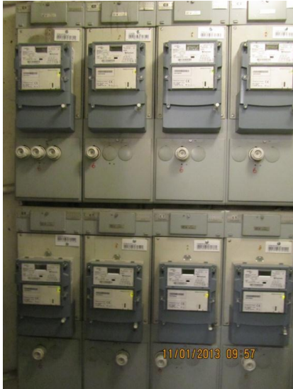
Lägenhetsmätare i elrum för respektive trapphus
