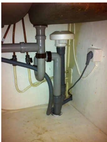
Avloppsrör av plast till diskbänk (under skivan), vacuumventil indikerar problem med luftningsledningen
