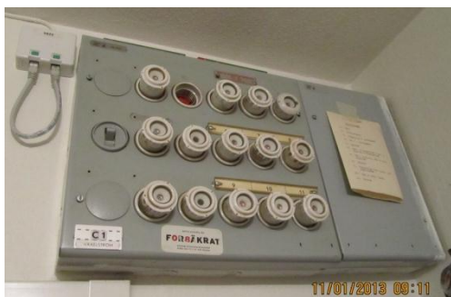
Lägenhetscentral av typ gängsäkringscentral
