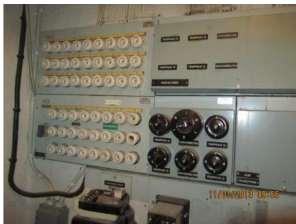
Fastighetscentral av typ gängsäkringscentral
