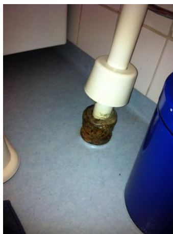
Avlopp av gjutjärn till tvättställ, risk för otät anslutning mot vattenlås
