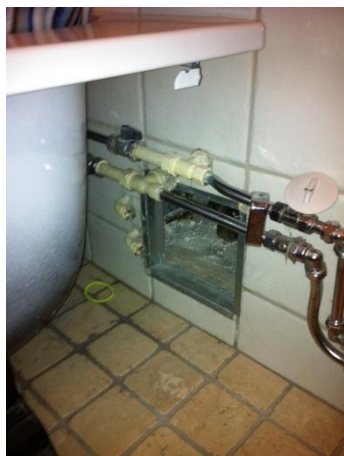
Rör kommer ut ur väggen bakom badkar avlopp, (inom våta zonen), risk för skada
