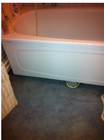
Golvbrunn av gjutjärn, risk för läckage pga korrosion samt otät anslutning mot tätskikt
