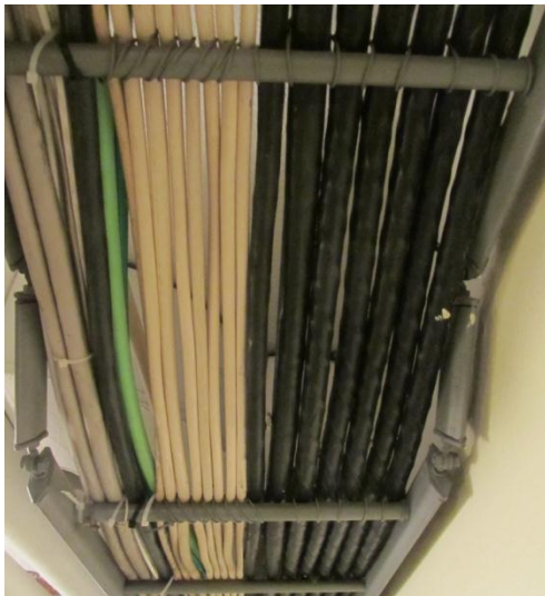
Huvud-, grupp- och teleledningar på stege i källare
