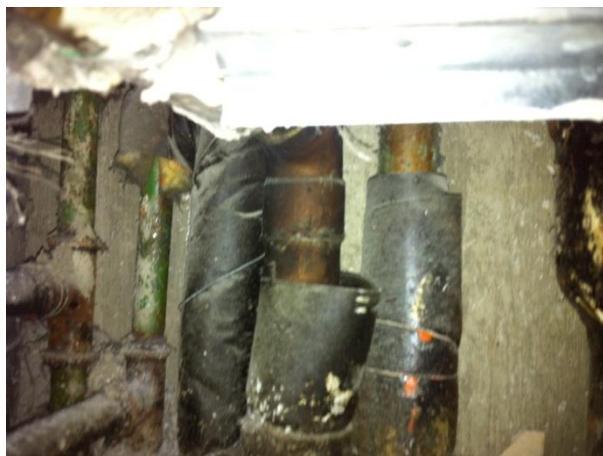
Rörlits i badrum med värme, kall- och varmvatten, VVC samt rören har bristfällig isolering
