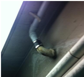
Avloppsrör i garage, delvis utbytt
