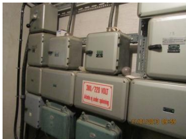
Servis- och huvudcentral i källarvåningen
