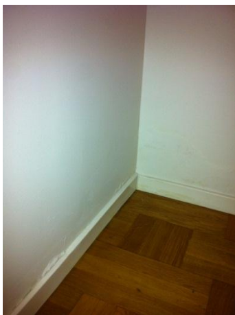
Fuktskadad vägg i vardagsrum mot badrum, orskatat av läckande värmerör pga korrosion utifrån
